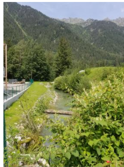
Le bassin de décantation
