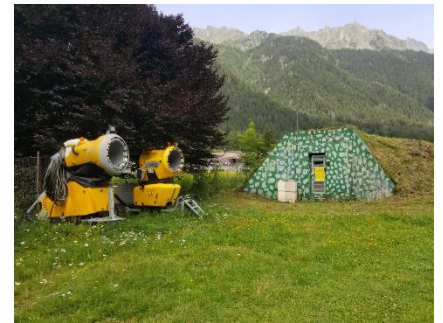
Le local de pompage
